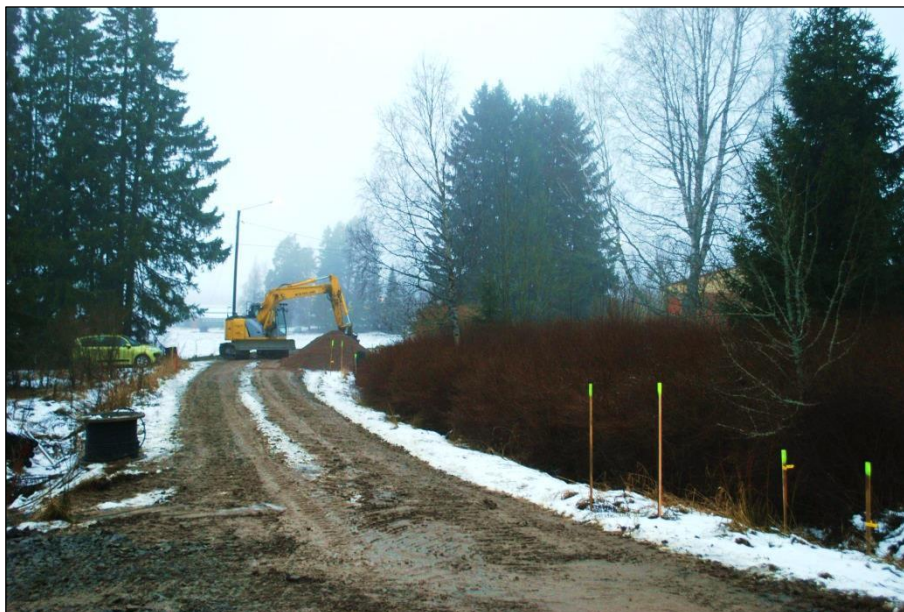
Tutkimusalueen kaakkoisosa ennen kaivutöiden aloittamista. Luoteeseen.
