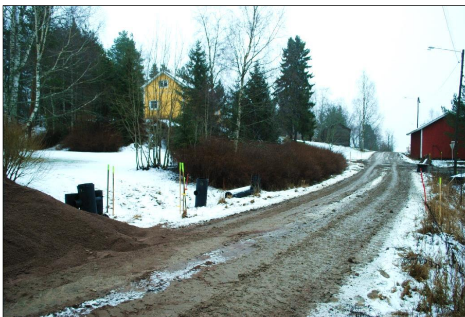
Tutkimusalueen luoteisosa ennen kaivutöiden aloittamista. Kaakkoon.
